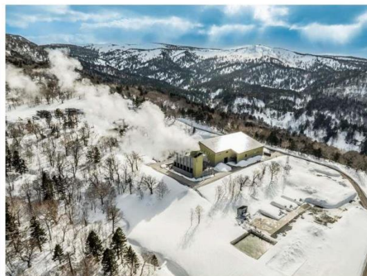
冬の安比地熱発電所
