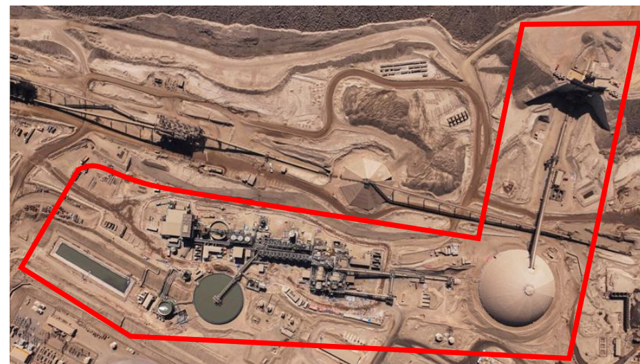
<上空からの全景>
