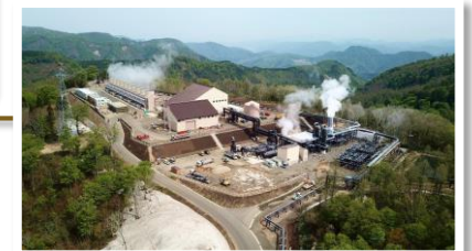
地熱：秋田県湯沢市 山葵沢地熱発電所運転開始 （2019年5月）
