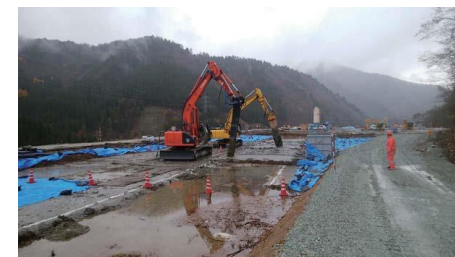
八谷鉱山 第一集積場安定化工事
