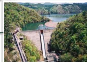
水力：秋田県森吉ダム 小又川新発電所着工 （2019年5月）
