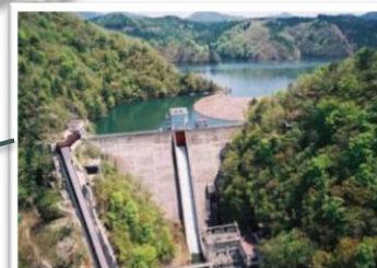
水力：秋田県森吉ダム 小又川第四水力発電所
