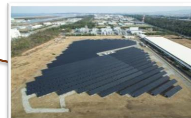
メガソーラー： 福井県福井市 福井太陽光発電所
