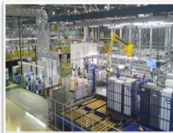
家電リサイクル 冷蔵庫処理ライン
