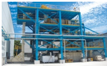
九州工場黒崎地区 都市ごみ焼却灰資源化プラント
