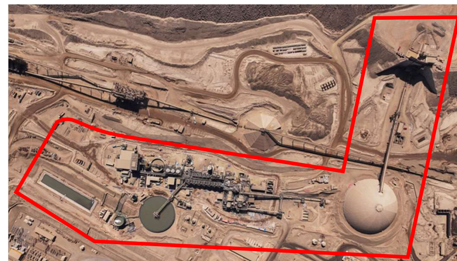
<上空からの全景>
