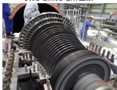
タービン解放点検状況（10月）
