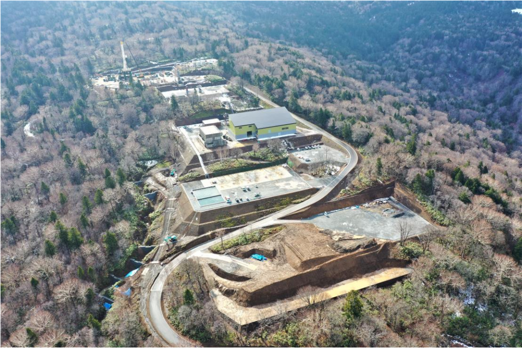
安比地熱発電所
