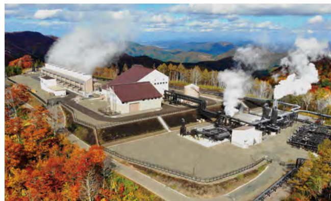
山葵沢地熱発電所（秋田県湯沢市）
