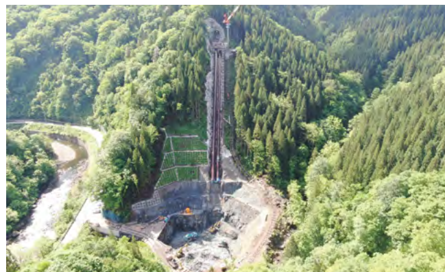
小又川新水力発電所（秋田県北秋田市）（建設中）
