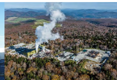
安比地熱発電所
