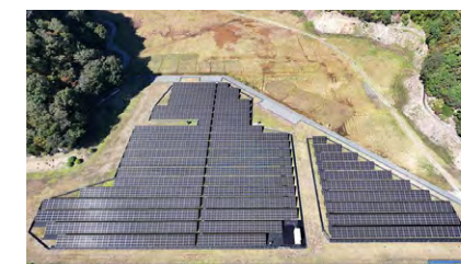
鳥の奥太陽光発電所
