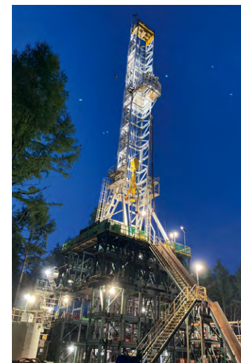
菰ノ森地域の調査井掘削
