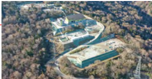
安比地熱発電所(建設工事全景)
